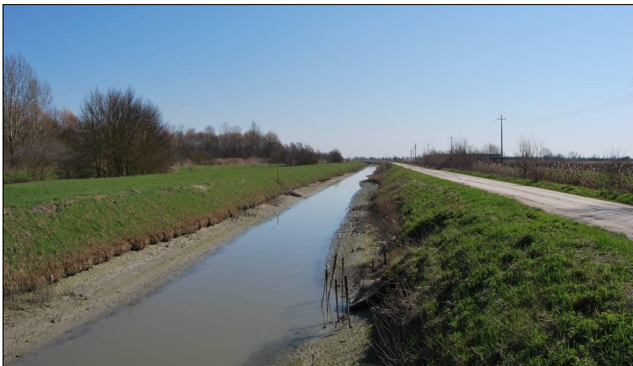
Canale all'interno dello ZPS
